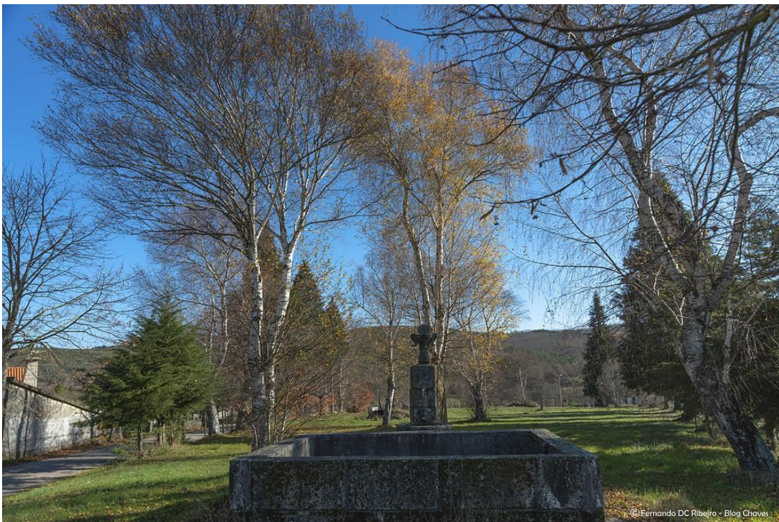
Foto 29 – Chafariz e bebedouro da aldeia de Vidoeiro
