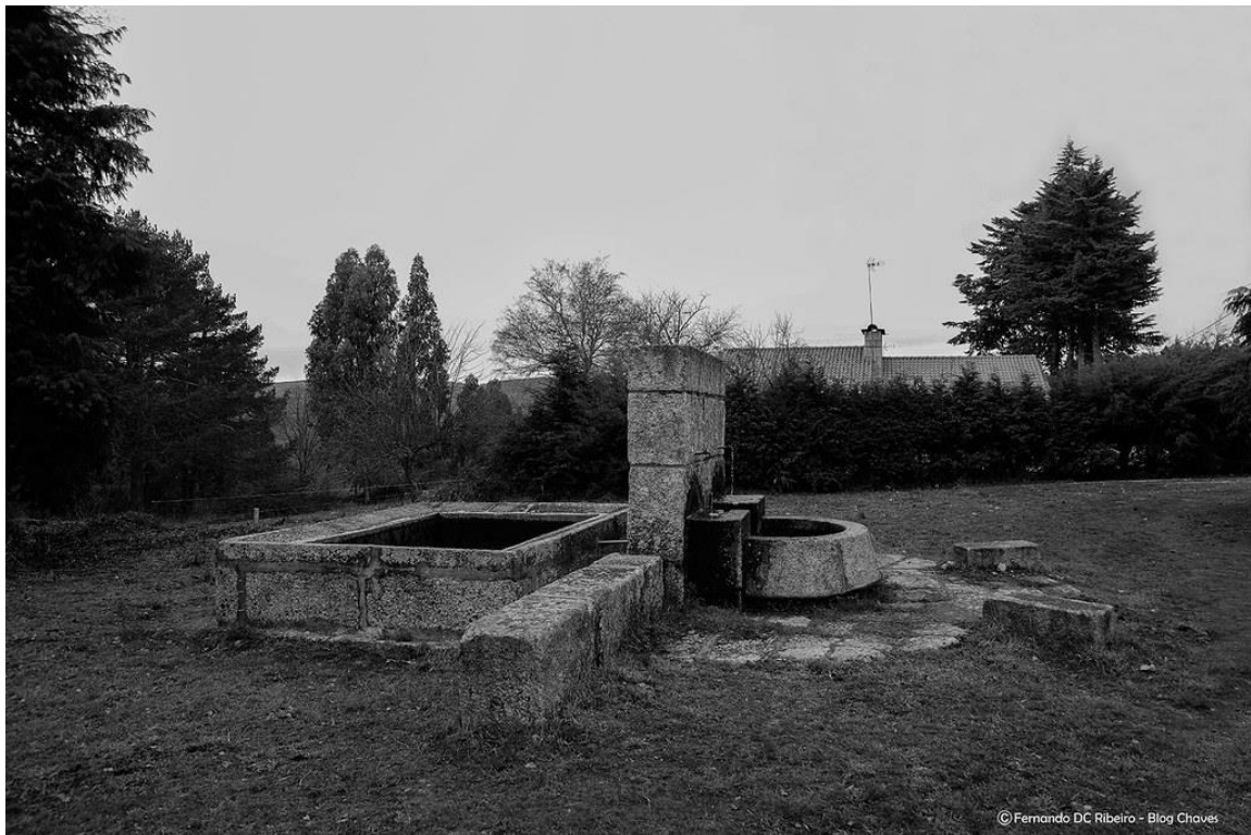
Foto 43 – Chafariz e tanque da aldeia de Fontão
