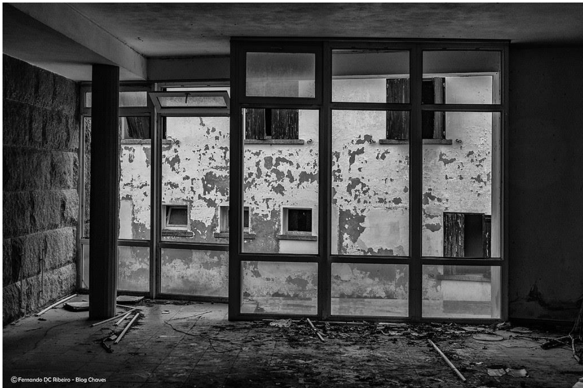
Foto 50 - Centro Social, interior dos edifícios
