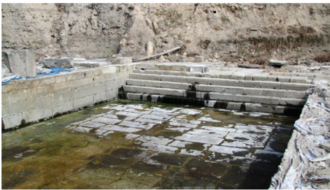
Figura 6 – Piscina A, lado Norte.
