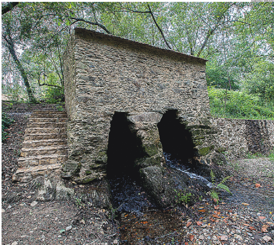
Os engenhos do passado voltam a trabalhar para a comunidade
