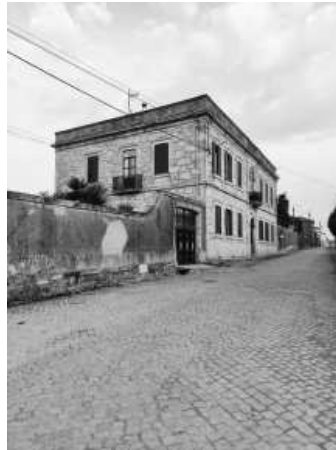
Casa em Malta - Vila do Conde. Onde José Júlio da Costa esteve escondido
