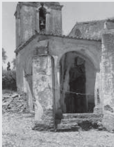
Galilé que protegia a cantaria do portal Manuelino na Igreja Matriz de Garvão
