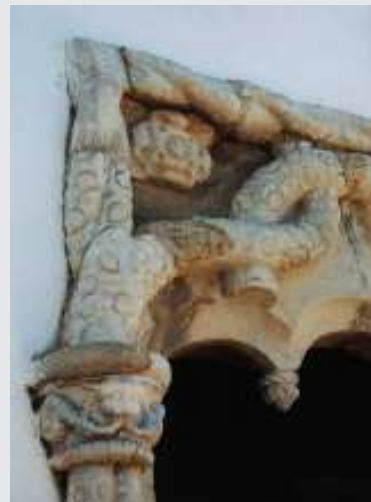
Remendos em cimento na cantaria do portal Manuelino
